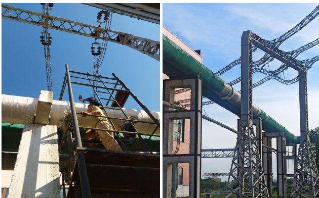
Зураг 4. Дулааны төв шугам болон генераторын гаргалгын цахилгаан дамжуулах шугамтай огтлолцож буй байршил
